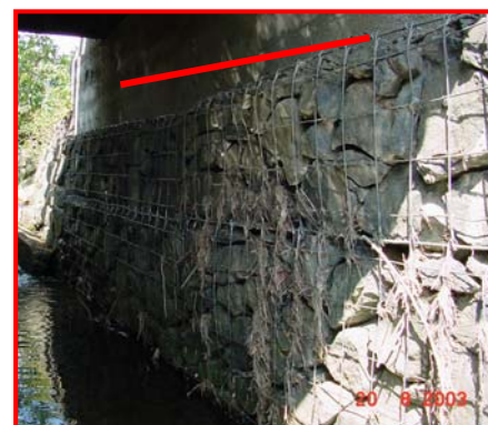
Zpevnění koryta propustku.
