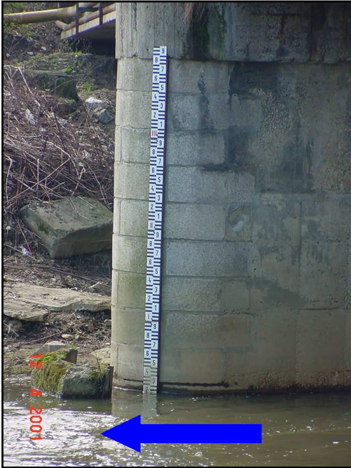
Lať je umístěná na mostním pilíři pravého břehu na vnitřní poproudni straně.
