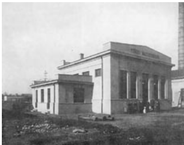
Obr.79. Čerpací stanice Tuhnice
