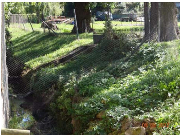
Pletivový plot přes koryto u areálu sádek.
