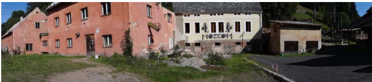
Celkový pohled na objekty služeb a výroby (momentálně nevyužívané). Úsek krytého profilu toku.
