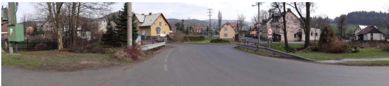
Centrum obce s mostem 2204-1, ten bude pravděpodobně přelit a dojde k významnému omezení dopravy.
