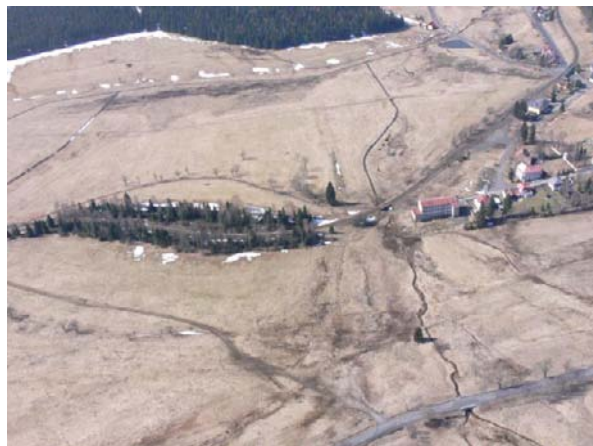
Silniční most 221-041 a železniční viadukt v trase toku.
