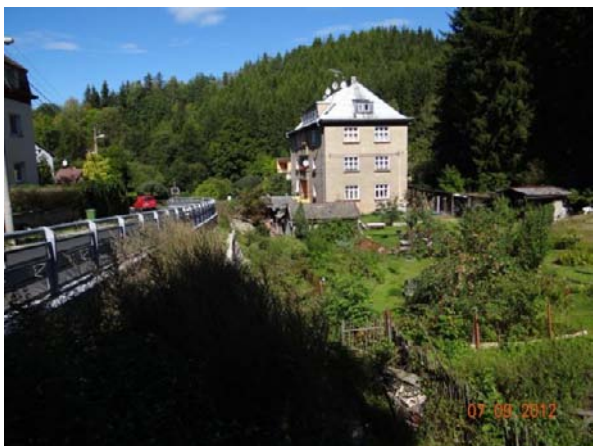
Ohrožená bytová zástavba v Březové (č.p. 145).
