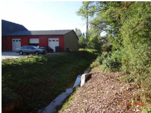
Mírně ohrožený objekt Ventop.
