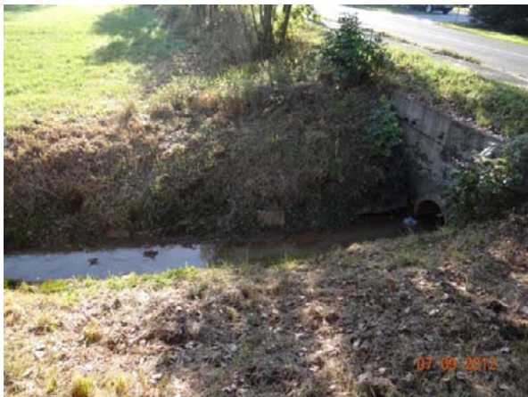
Trubní propust v tělese komunikace.
