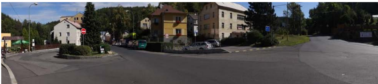
Ohrožené nemovitosti pod školou (krytý profil toku).
