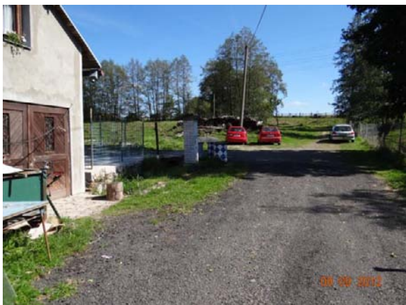
Ohrožená cesta a nemovitosti v místě krytého profilu toku.
