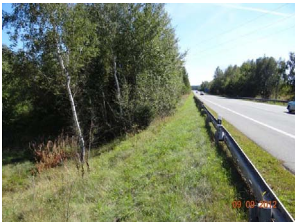
Těleso náspu komunikace I/20.
