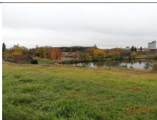
Obr. 29 Pohled na hráz mezi prostředním a dolním rybníkem
