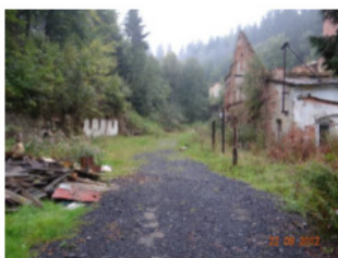
Areál bývalé cihelny.
