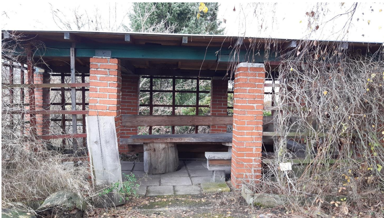
Současný stav přístřešku s posezením (foto autor, 11/2021)
