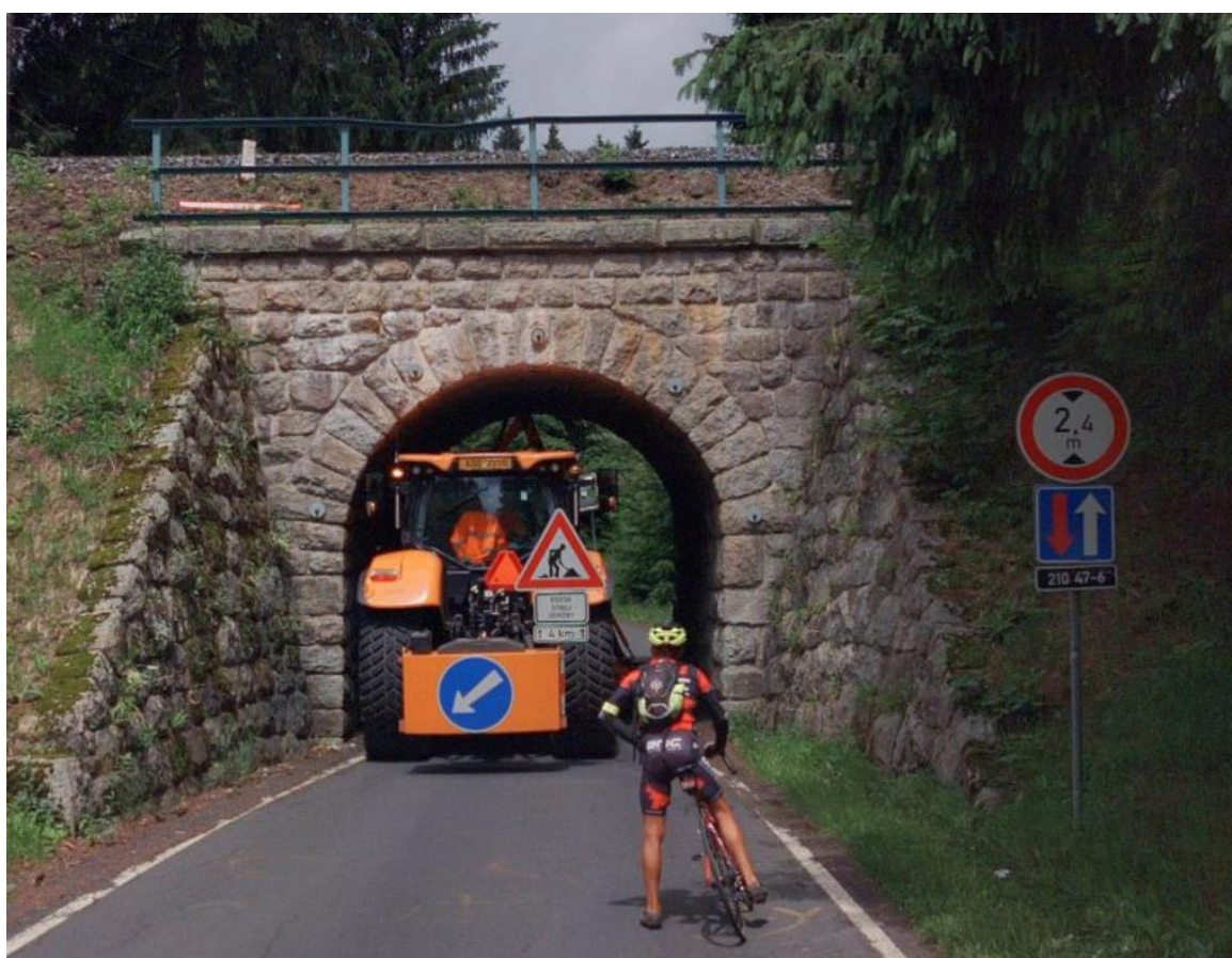
Obrázek 2. Viadukt (ev. číslo objektu 21047-6) pod železniční tratí č. 142 Karlovy Vary – Nová Role – Nejdek – Potůčky (zdroj Mapy.cz)
