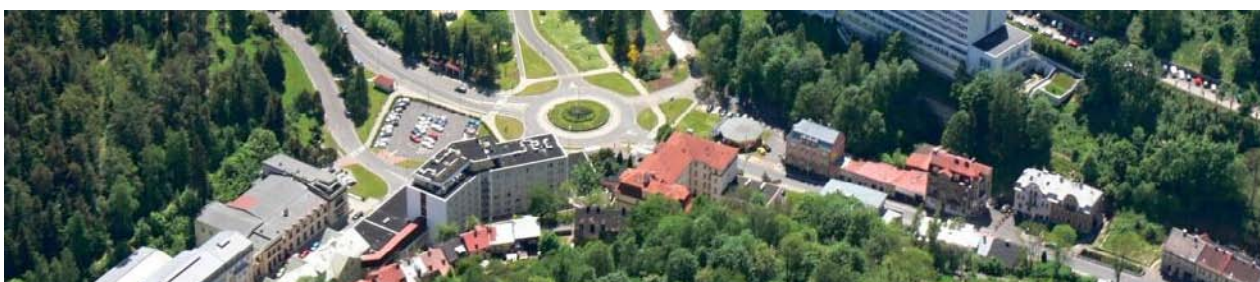
Celkový pohled na ohroženou lokalitu ulice K lanovce a kruhového objezdu.
