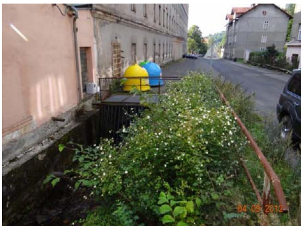
Nátok do krytého profilu (česle) - kritické místo pro Jáchymov.
