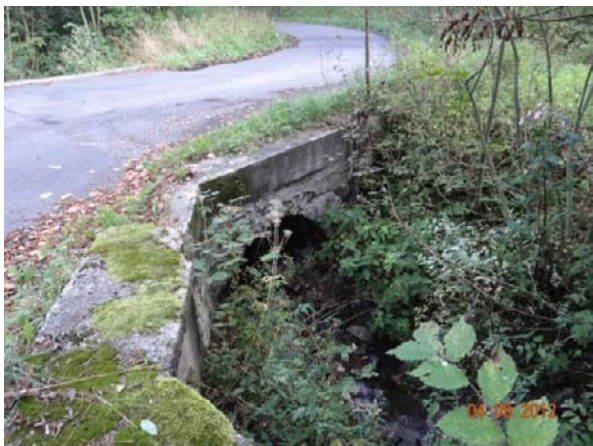
Most nad č.p. 48 - cesta do VÚ.
