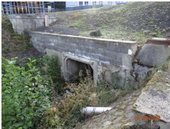
Vyústění krytého profilu za vrátnicí do areálu.
