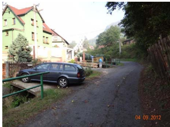
Ohrožená zástavba podél Pekelského potoka.
