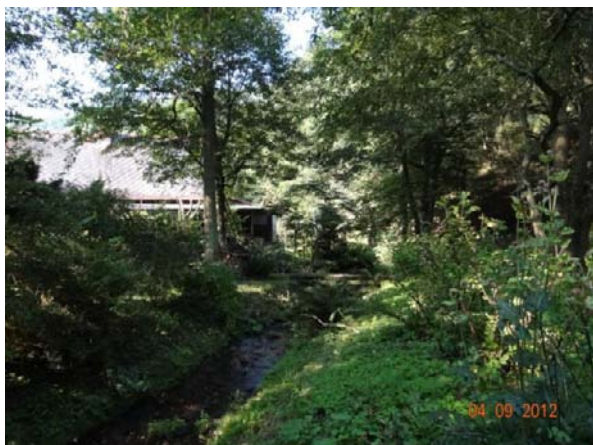
Tok podél objektů č.p. 163 a 162.
