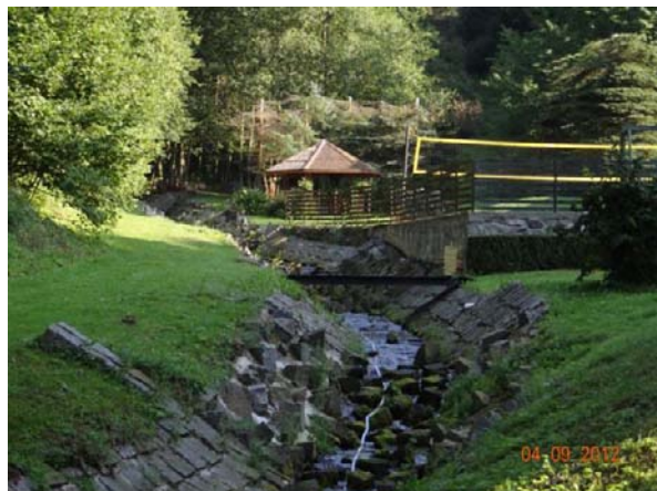
Regulované koryto podél objektu č.p. 167.
