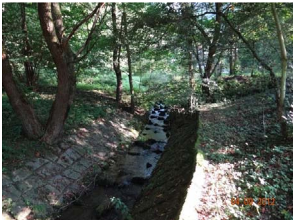
Tok podél objektů č.p. 163 a 162.
