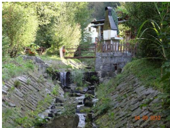
Regulované koryto podél objektu č.p. 166.
