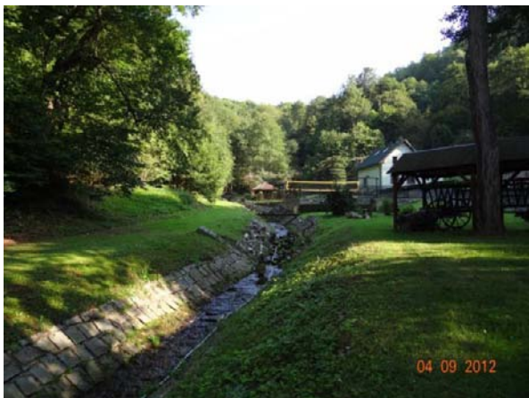
Regulované koryto podél objektu č.p. 167.
