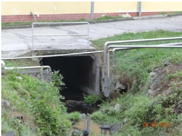
Detail nátoky do krytého profilu.
