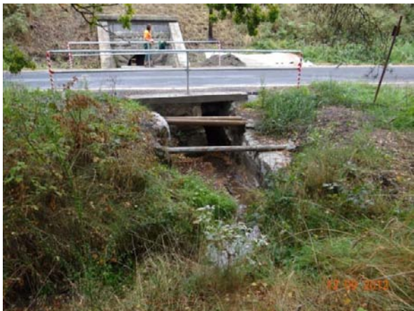
Silniční a železniční propusti na Lužním potoce ve Velkém Luhu.
